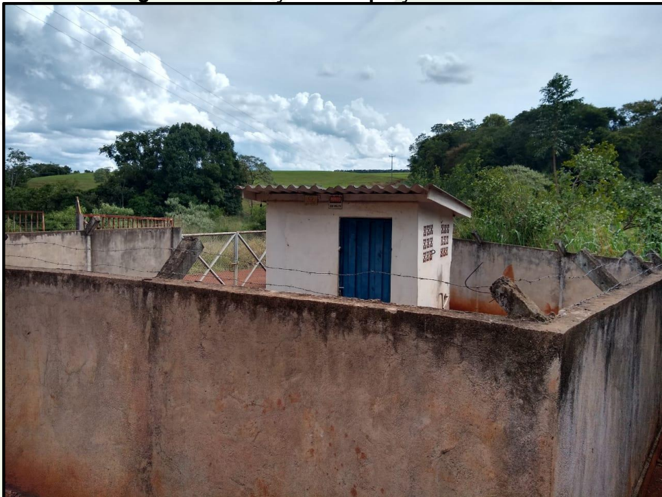
Figura 13 – Estação de Captação Vila Rural 1
