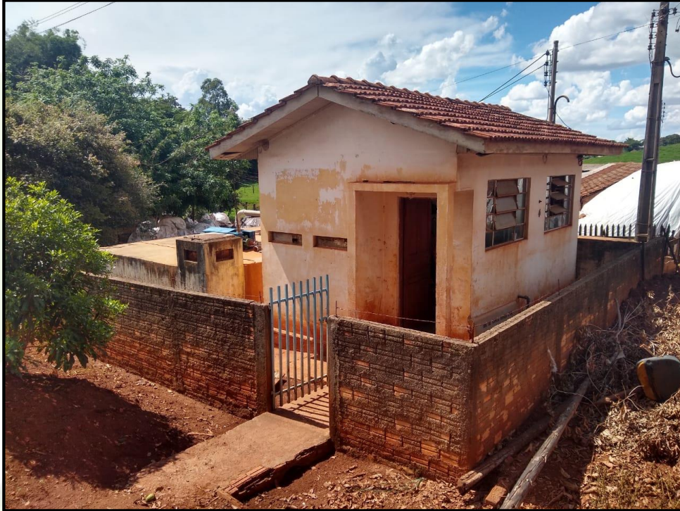
Figura 12 – Estação de Captação Canedo
